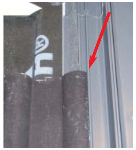
Beenden Dachdeckung bis höchste Einfassungsrinne
