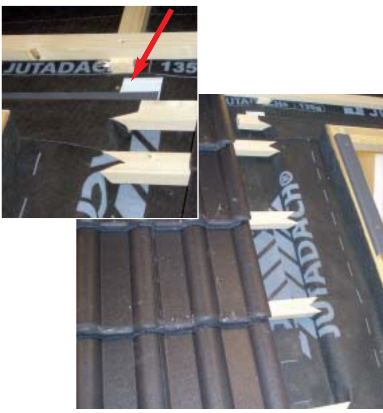
Die Anfügung sicherungs Wasserisoliertolie und Bemmanung Dränrinne
